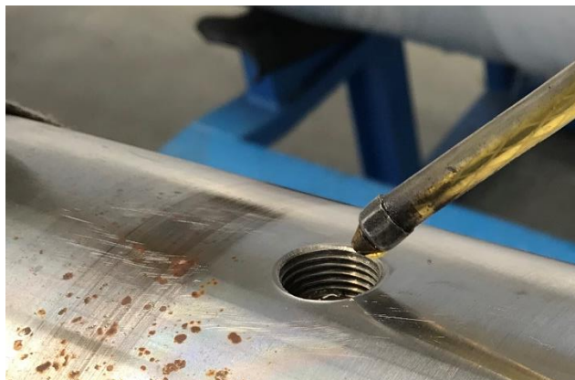
Figura 96: Inserção do óleo hidráulico
