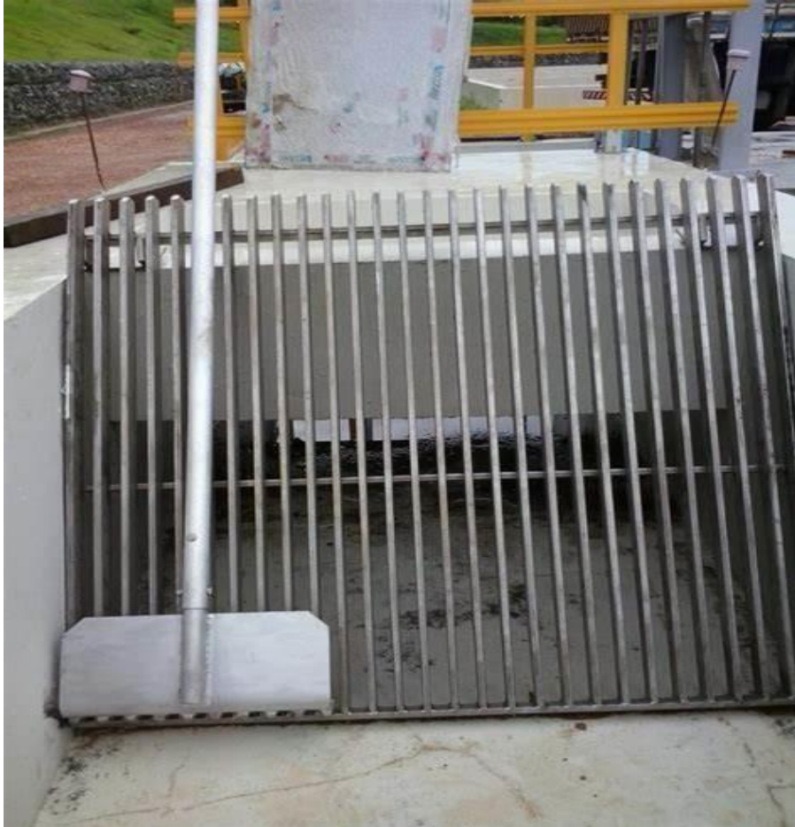
Figura 4: Gradeamento de limpeza manual.
