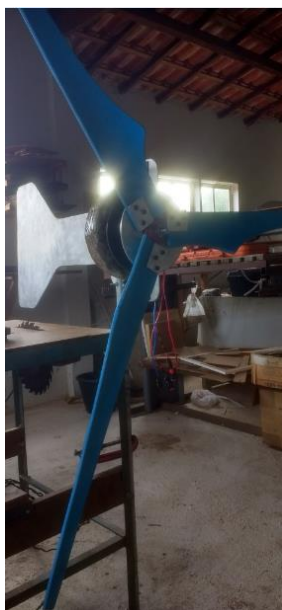
Figura A 73 – Montagem da turbina eólica.
