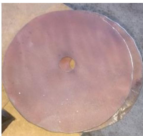
Figura A 50 - Estrutura dos rotores do gerador após limpeza.
