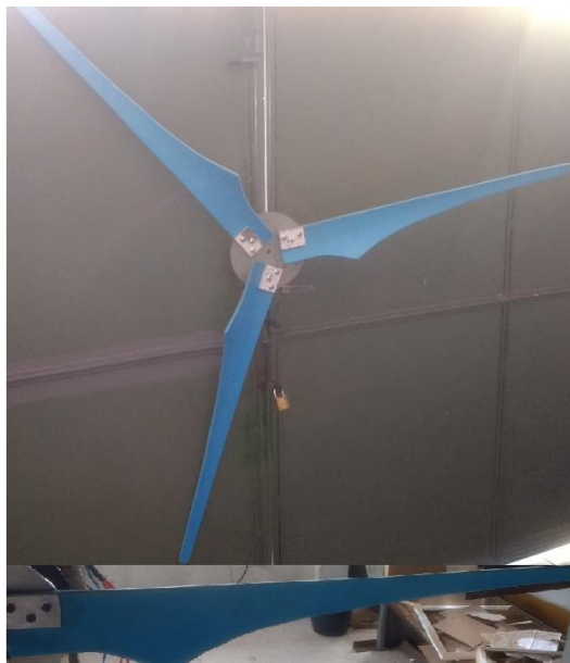
Figura A 29 - Pré-montagem da turbina do aerogerador.
