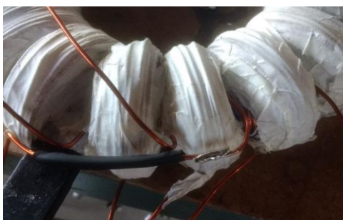
Figura A 55 - Fechamento das bobinas.
