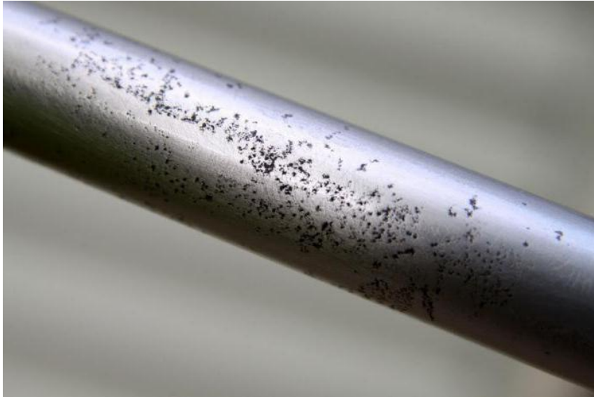
Figura 12 Exemplificação da corrosão do tipo puntiforme.
