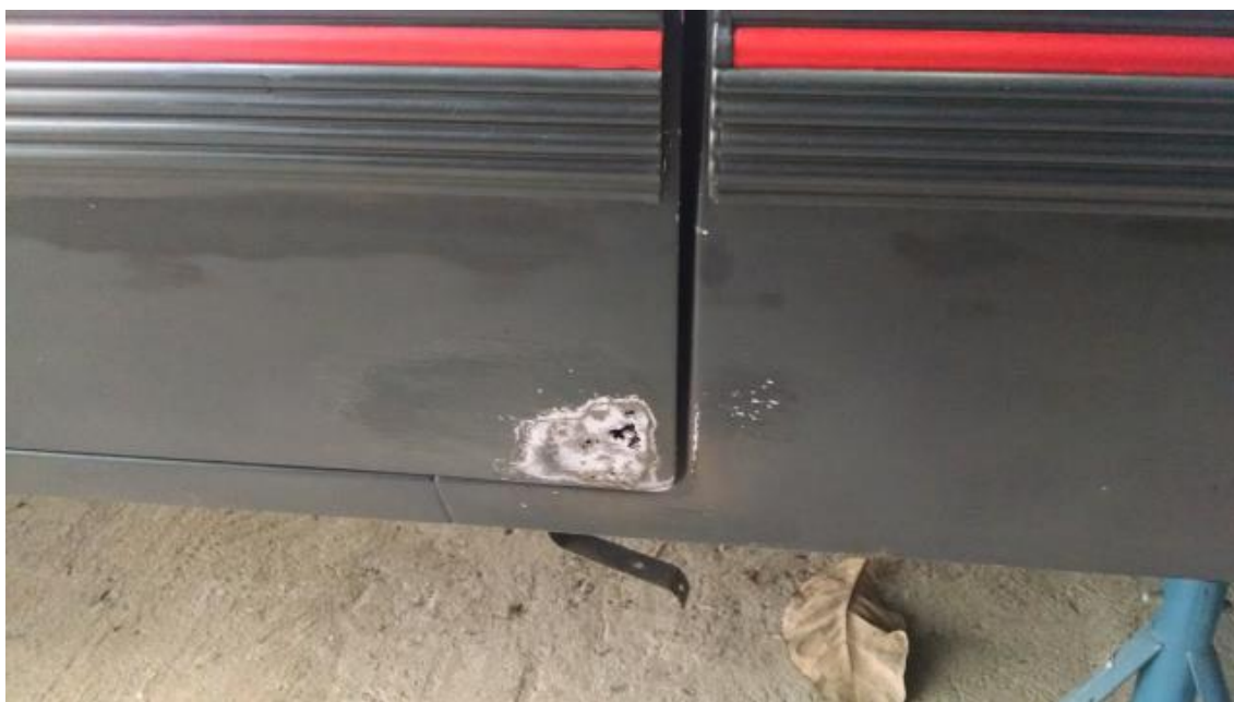
Figura 31 Estufamento de tinta devido a uma aplicação deficiente de pré tratamento da chapa metálica.
