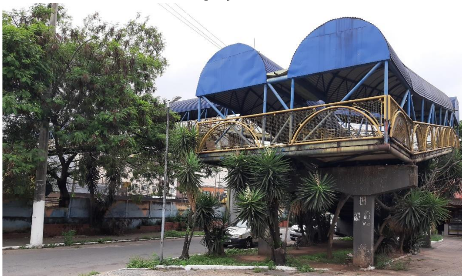
Figura 19: Passarela que Transpõe a Rodovia Lúcio Meira, o Parque Ferroviário da CSN e a Avenida da Integração no Bairro Aterrado, Volta Redonda
