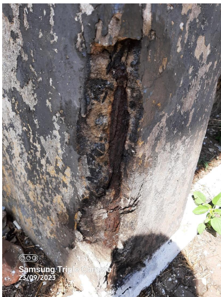
Figura 22: Pilar 1 – Carbonatação
