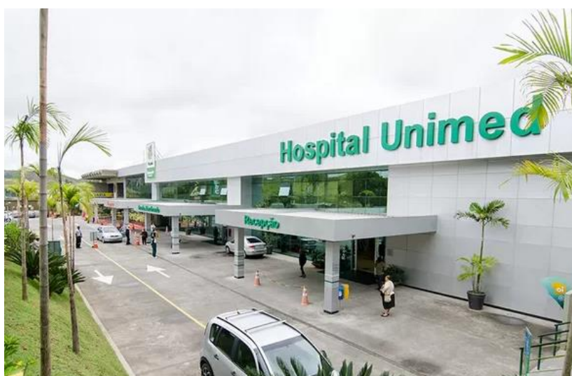
Figura 7. Hospital Unimed Volta Redonda
