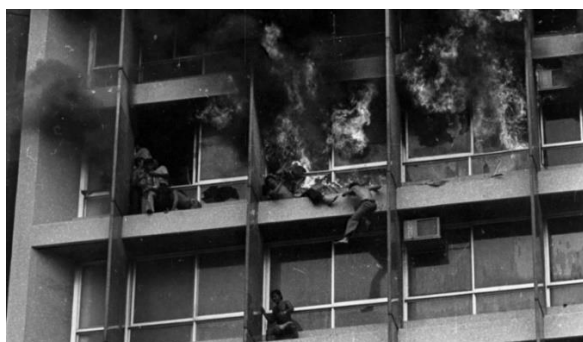
Figura 6 - Edifício Joelma em chamas
