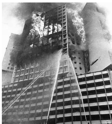
Figura 7 - Edifício Joelma em chamas e recebendo a ação dos esguichos de água
