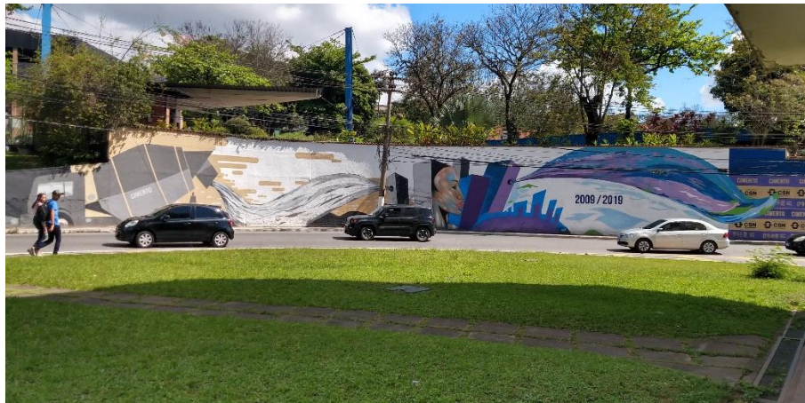
Figura 30: Muro Vila Sta. Cecília – Depois.
