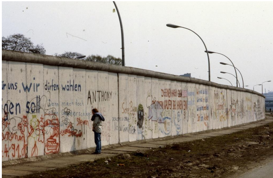
Figura 12: Muro de Berlim – Lado Ocidental.
