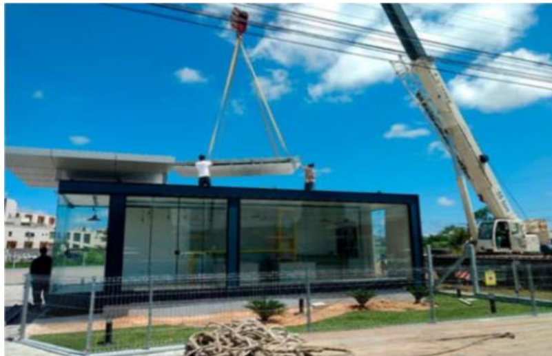
Figura 10 - IÇAMENTO DE TELHAS NA INSTALAÇÃO DO MÓDULO
