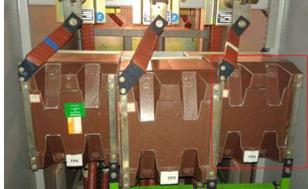
Figura 11- TP utilizado para medição da frequência do grupo
