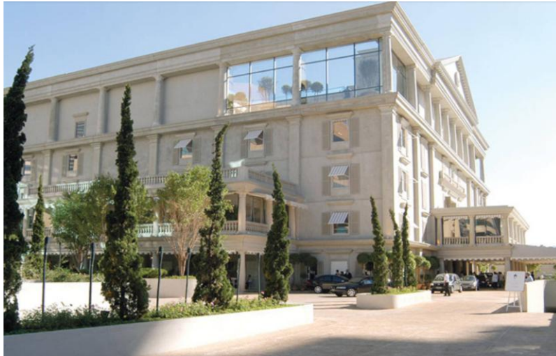
Figura 1: Fachada da Daslu em São Paulo.
