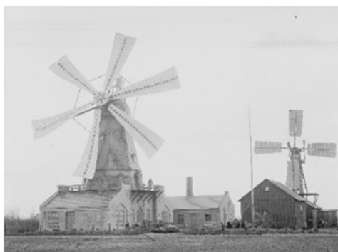
Grande turbina eólica de Poul la Cour de 1897
