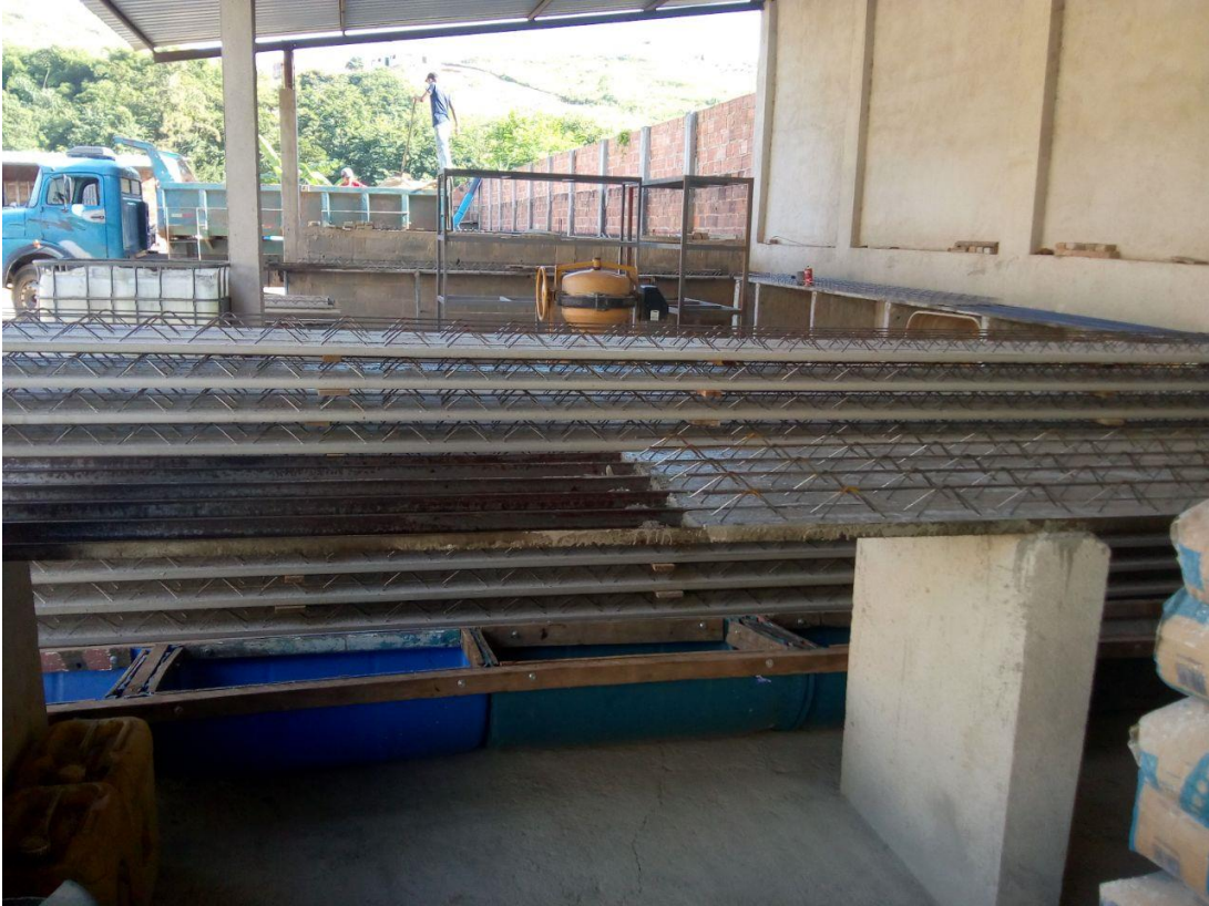
Figura 6 – Fotografia da produção de laje Fonte: Autores
