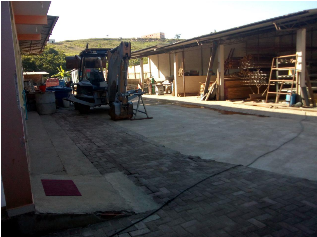
Figura 7 – Fotografia da produção de laje Fonte: Autores
