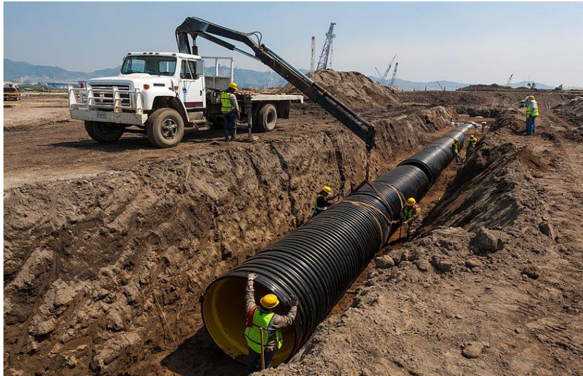
Fotografia 9: Instalação de tubo corrugado num projeto de drenagem de tempestade no México.
