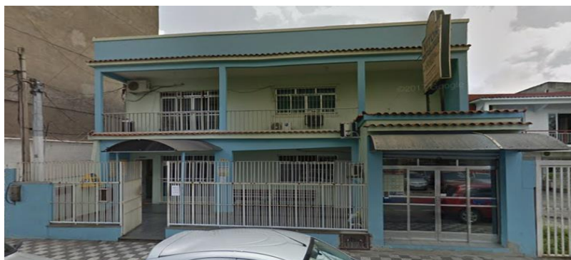
Figura 4: Fachada da empresa Vitor Contabilidade Fonte: Autores
