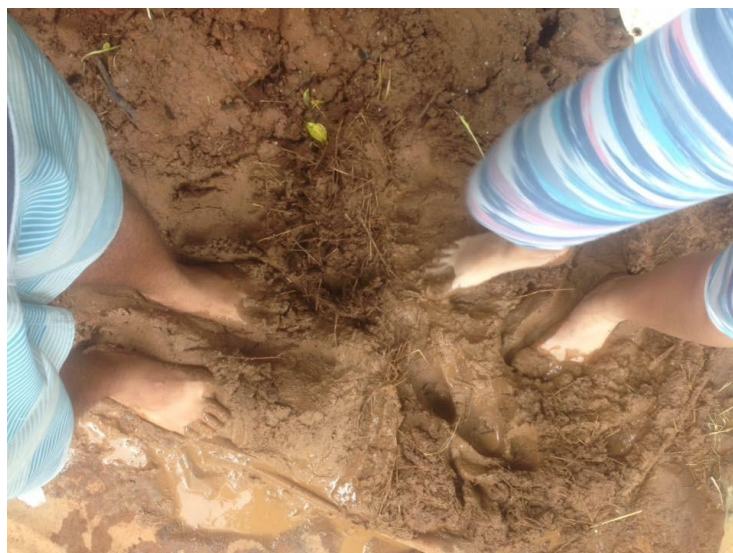
Figura 25: Amassamento e mistura do barro com água, terra e palha Fonte: Autores – 2016
