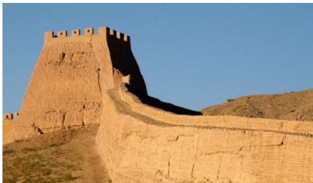
Figura 1: Trecho em Taipa de Pilão da Muralha da China – China Fonte: CRAterre – 2012
