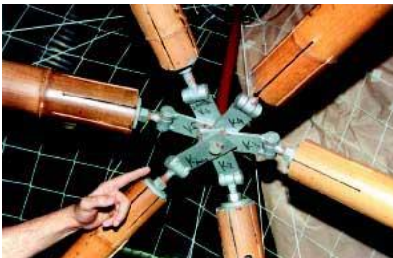
Figura 27: Conexões com utilização de presilhas em Aço. Fonte: UFMG – 2002
