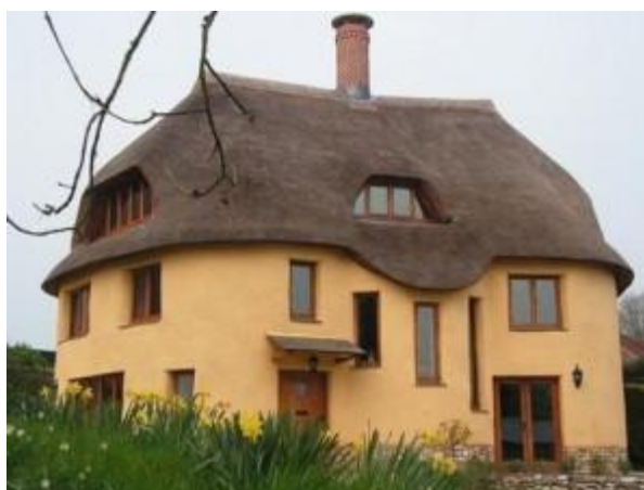
Figura 2: Casa em Cob na Região de Devon – Inglaterra Fonte: LIBNAM, s.d.
