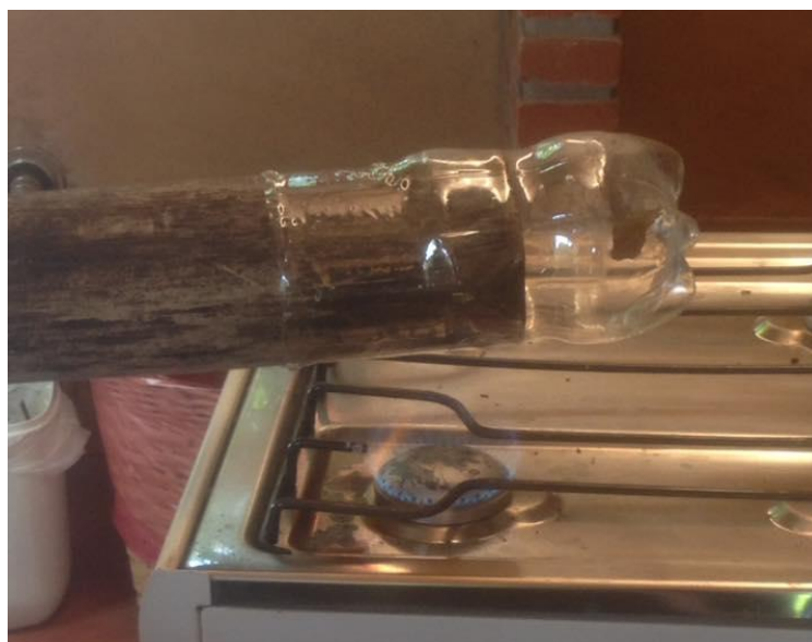
Figura 21: Preparação da fundação com proteção de garrafa PET Fonte: Autores – 2016
