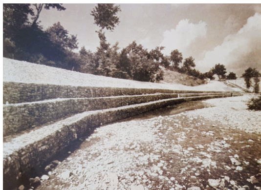
Figura 14: Proteção longitudinal e contenção da estrada que margeia o curso do rio Sillaro em Bolonha.
