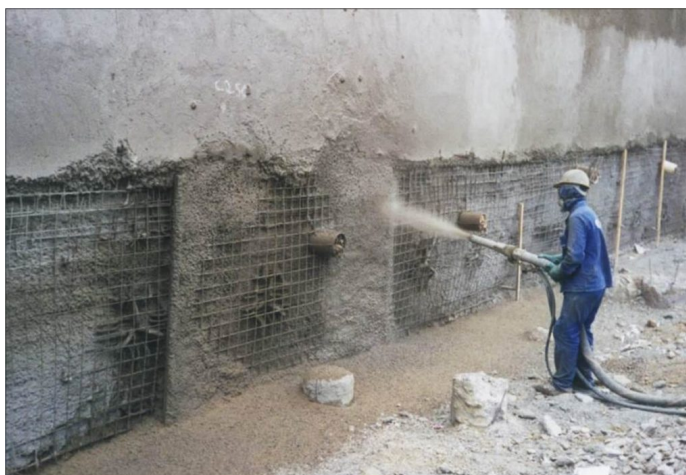
Figura 32: Camada de concreto sendo aplicada sobre a malha de ferro. Fonte: Tecnosil, 2020.
