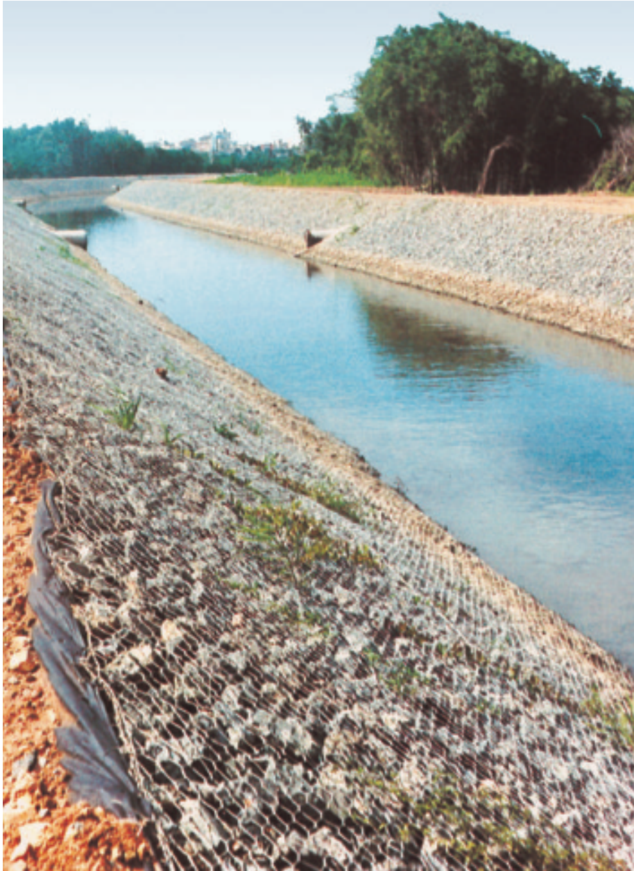
Figura18: Canalização de córrego em Colchões Reno.
