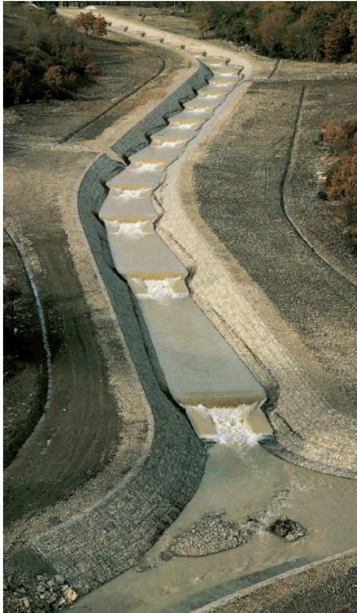
Figura 19: Aplicação do colchão de Reno nas margens de um rio.
