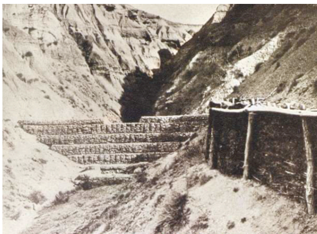
Figura 12: Dique para retenção de sólidos na Etiópia Fonte: AGOSTINI et al. , 1981.
