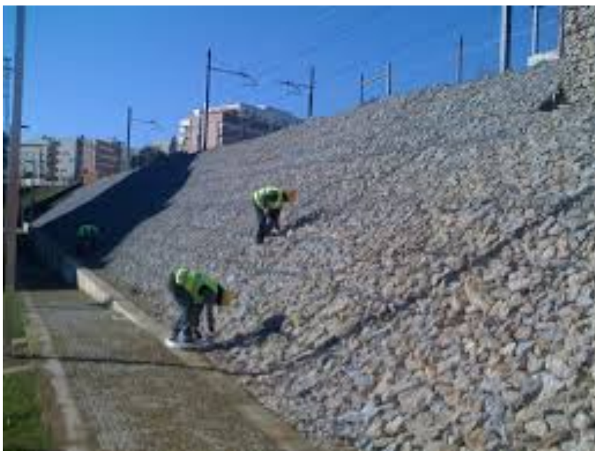
Figura 20: Aplicação do colchão de Reno em um talude.
