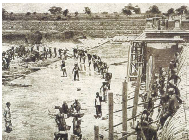
Figura 13: Sistematização marginal ao lado da barragem de Genale na Somália. Fonte: AGOSTINI et al. , 1981.
