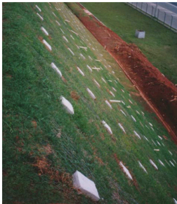
Figura 34: Revestimento em grama para obra de recuperação de talude com aplicação de solo grampeado
