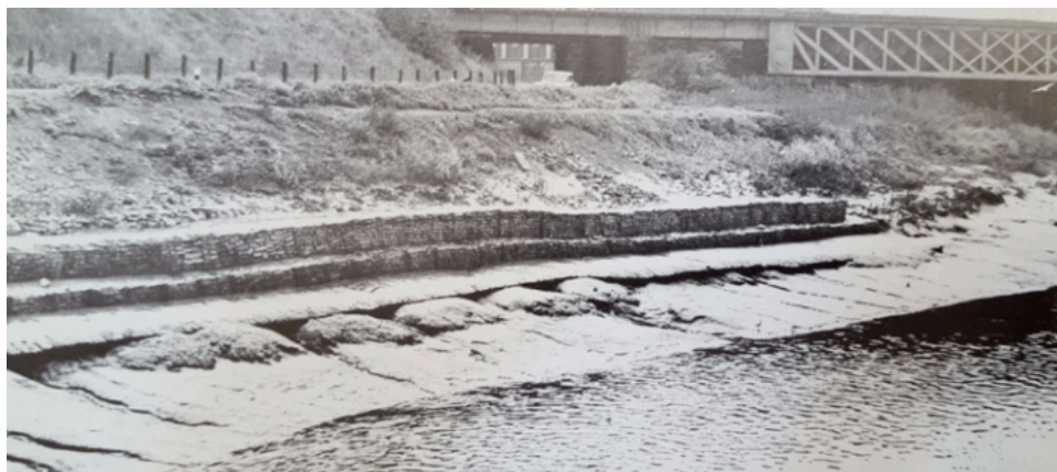
Figura 16: Os primeiros gabões plastificados. A foto mostra a obra terminada em 1954 em Bristol na Inglaterra.
