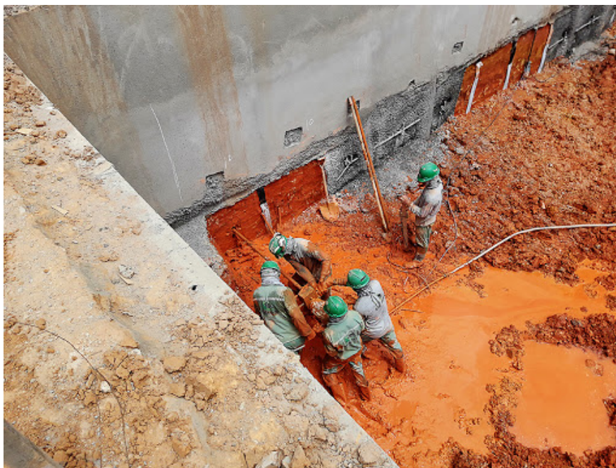
Figura 31: Escavação Fonte: SOLOTRAT, 2018.
