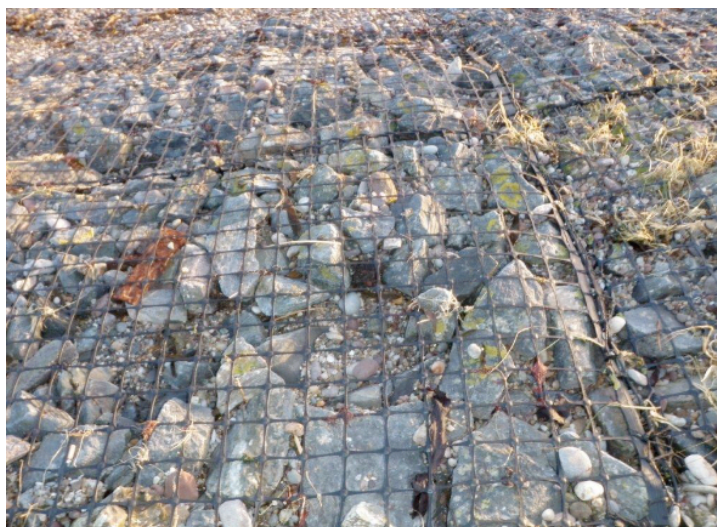
Figura 24: Gabião plástico preenchido com pedras
