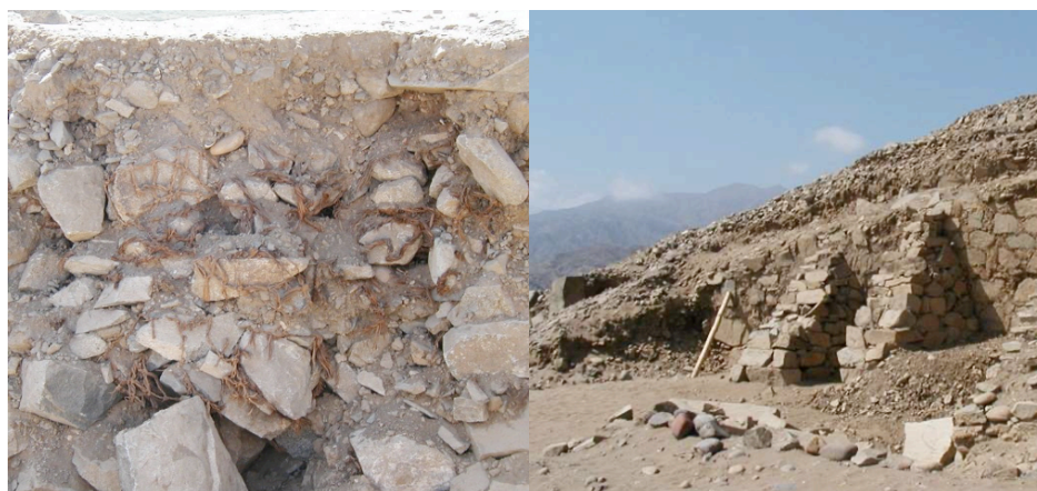
Figura 10: Muro com restos de fibras vegetais contendo pedras. Indícios de uso dos primeiros gabiões no Peru na cidade de Caral
