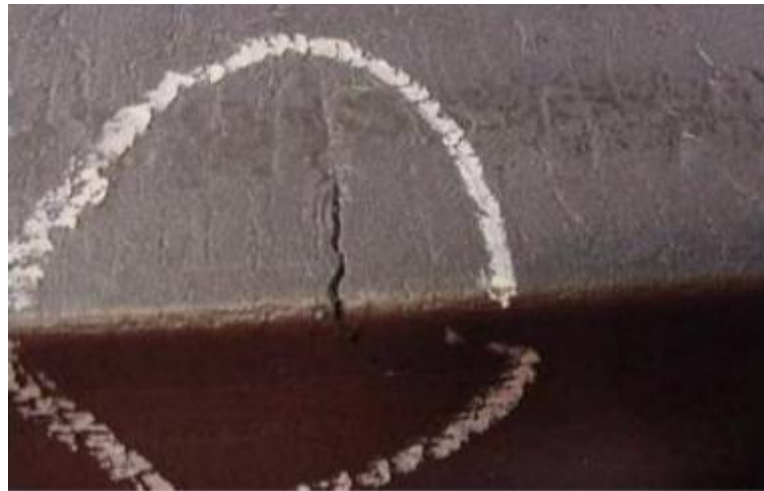
Figura 51: Superfície do tarugo com trinca transversal de canto
