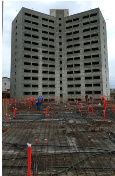
Figura 21 – Laje moldada Fonte: Condomínio da Fé (2020).
