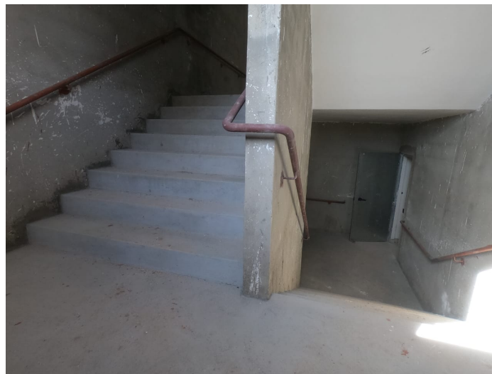
Figura 20 – Escada de emergência Fonte: Condomínio da Fé (2020).
