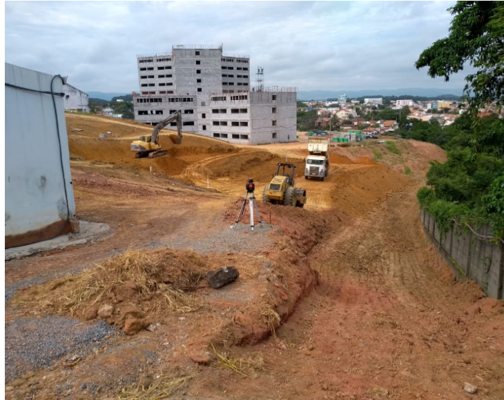
Figura 14 – Terraplenagem no terreno Fonte: Condomínio da Fé (2019).
