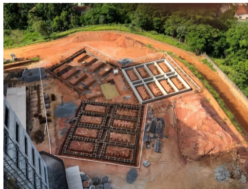
Figura 18 – Formação dos caixões Fonte: Condomínio da Fé (2020).
