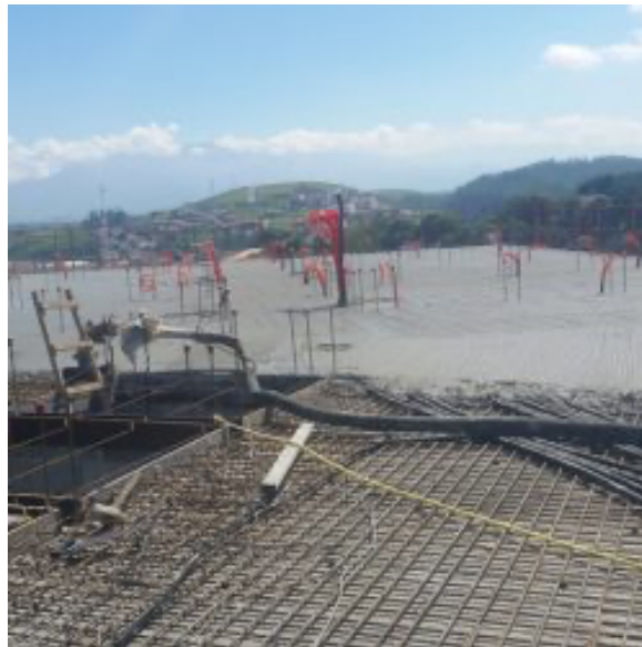
Figura 22 – Concretagem da Laje Fonte: Condomínio da Fé (2018).
