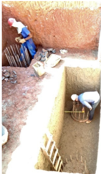
Figura 16 – Execução da fundação Fonte: Condomínio da Fé (2020).
