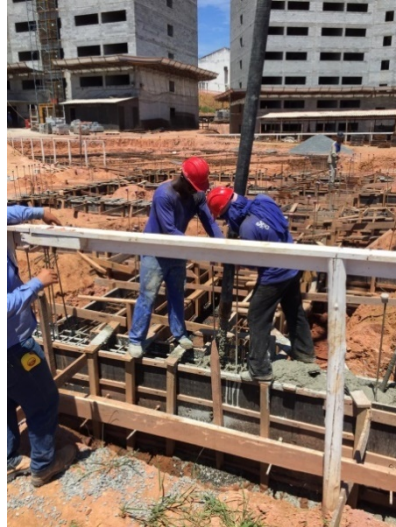
Figura 17 – Concretagem dos caixões Fonte: Condomínio da Fé (2020).
