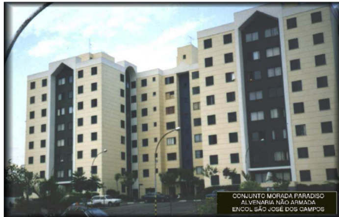
Figura 5 – Conjunto de Alvenaria não Armada - prédios com 08 pavimentos Fonte: Homepage Imóveis Mitula
