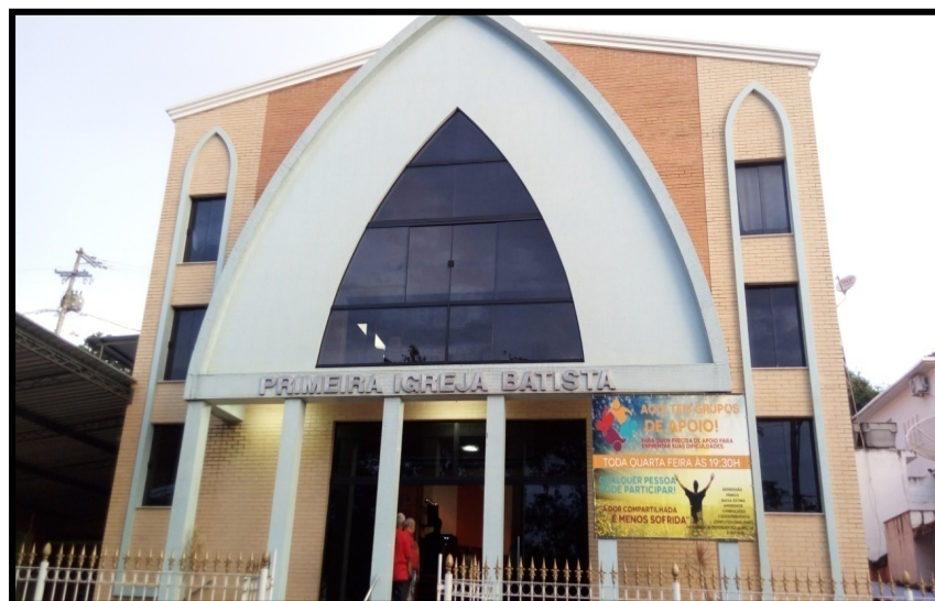
Figura 2 - Fachada da Primeira Igreja Batista de Barra do Piraí
