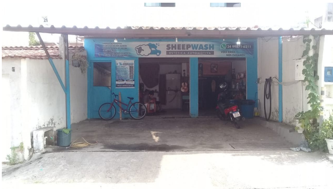
Figura 3 – Fachada da loja Fonte - < https://forms.gle/YSmnkJAxQTNR8vJQ8 >
