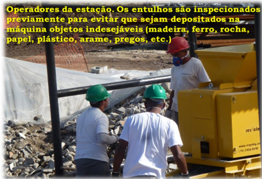
Figura 47- Estação de reciclagem de entulho
