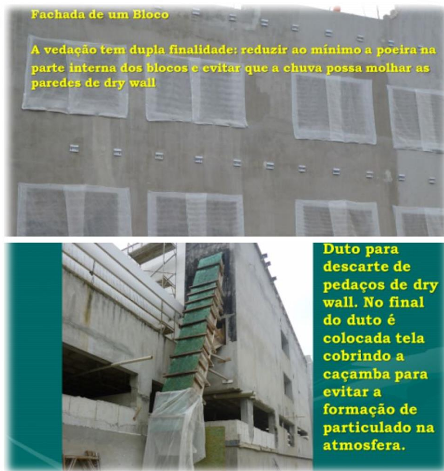
Figura 6- Controle da poluição do ar externo / interno Fonte: Acervo Pessoal do Engenheiro e Gerente de Meio Ambiente Francis Fixel, 2013.
