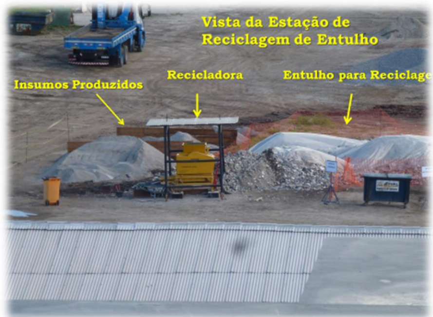
Figura 44- Estação de reciclagem de entulho Fonte: Acervo Pessoal do Engenheiro e Gerente de Meio Ambiente Francis Fixel, 2013 .
