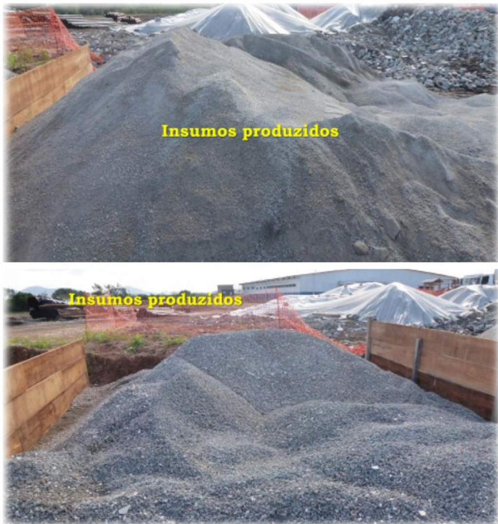
Figura 51- Estação de reciclagem de entulho Fonte: Acervo Pessoal do Engenheiro e Gerente de Meio Ambiente Francis Fixel, 2013 .
