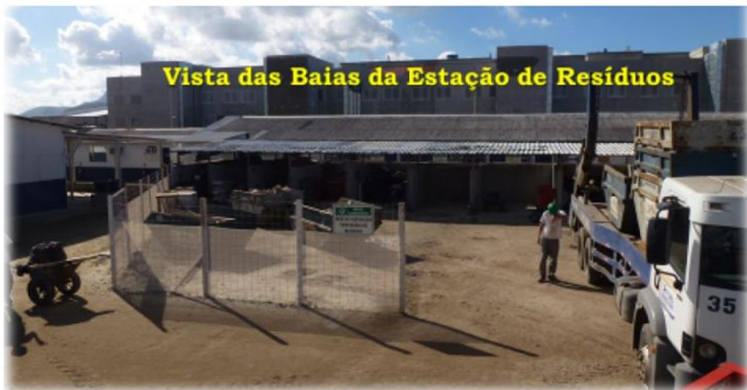
Figura 14- Segregação de Resíduos
