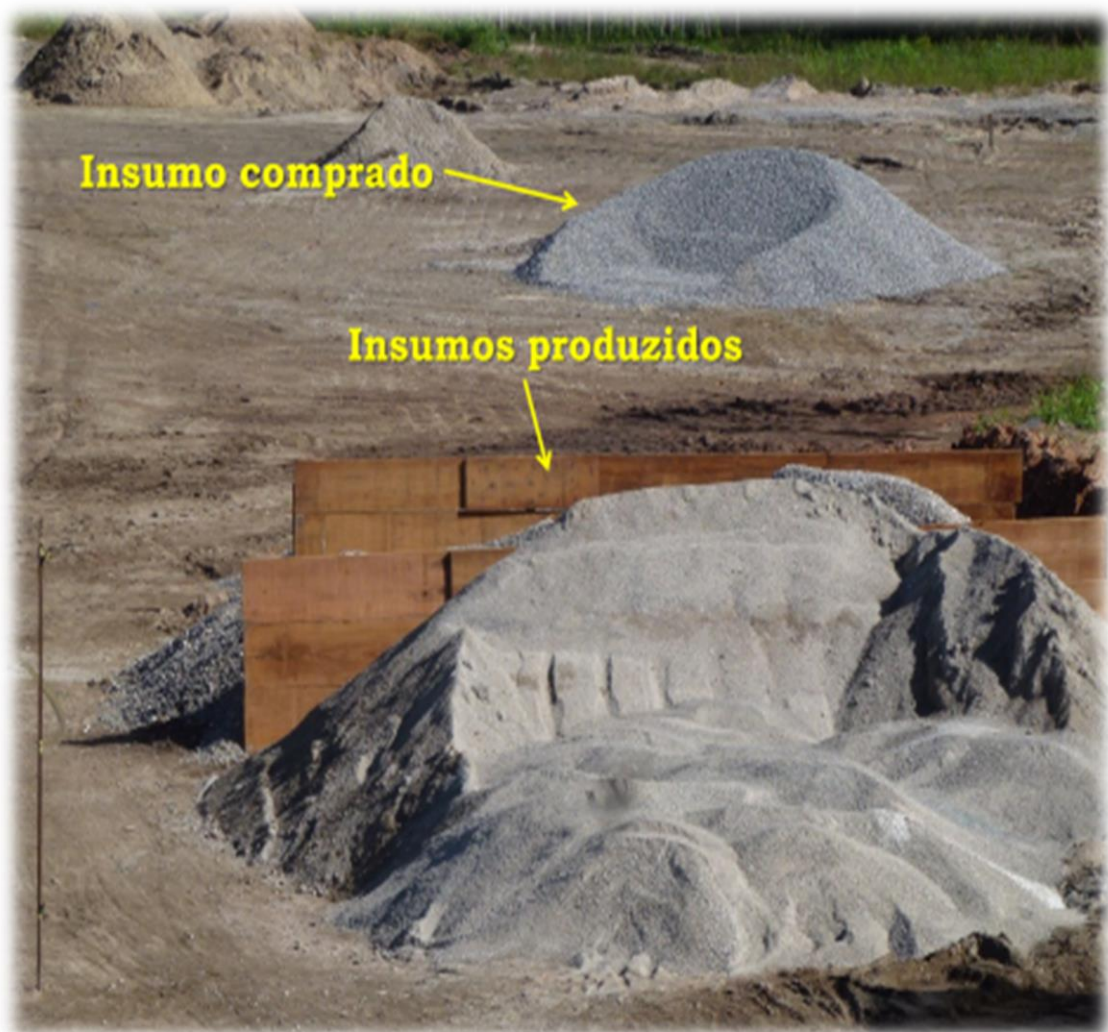
Figura 50 - Estação de reciclagem de entulho Fonte: Acervo Pessoal do Engenheiro e Gerente de Meio Ambiente Francis Fixel, 2013 .
