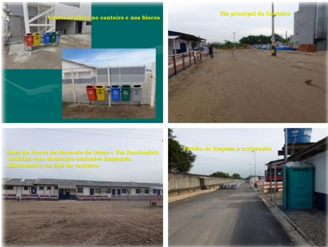
Figura 5- Limpeza do canteiro
