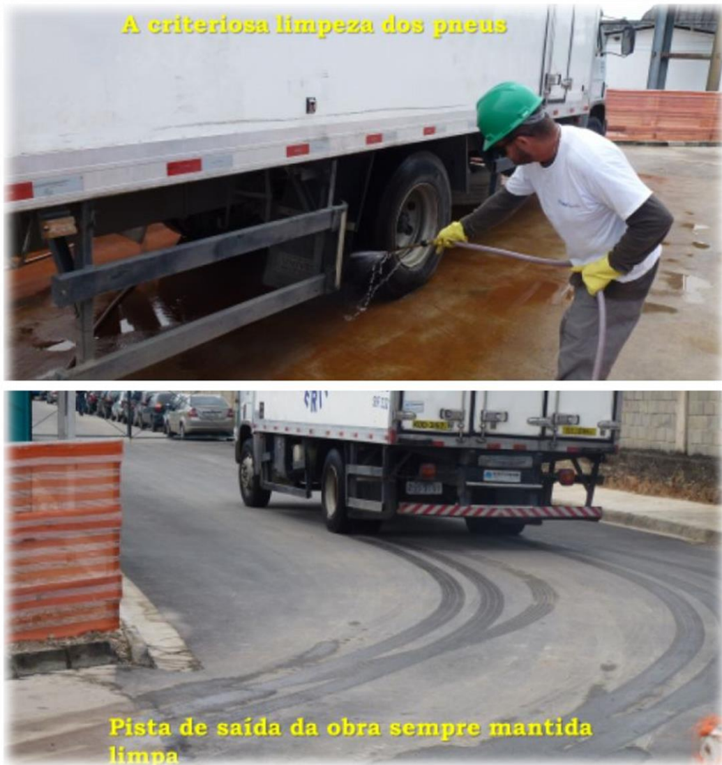
Figura 24- Controle da contaminação externa Fonte: Acervo Pessoal do Engenheiro e Gerente de Meio Ambiente Francis Fixel, 2013.
