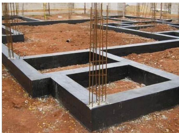
Figura 9 - Impermeabilização dos Baldrame
