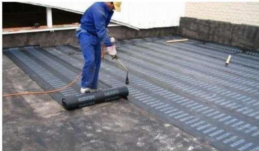
Figura 10 - Impermeabilização de Laje
