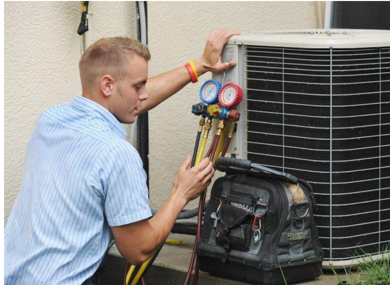
Figura 20: Verificação da serpentina
