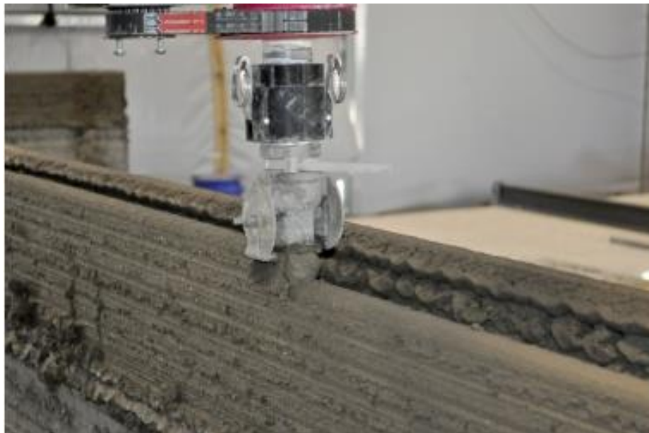
Figura 7 - Extrusão do Concreto Via Camadas.
