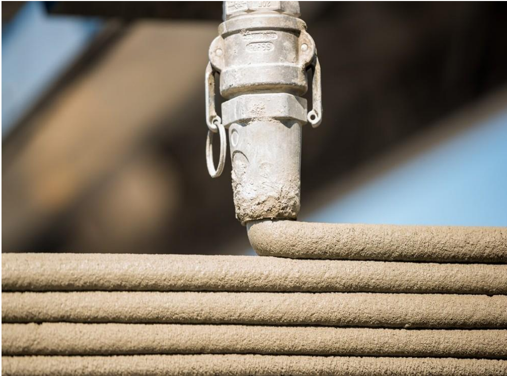
Figura 16 - Extrusão de Concreto Icon. Fonte: Foto: Divulgação, Icon.
