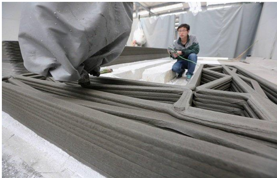
Figura 11 - Extrusão do Concreto na China. Fonte: DIGITALTRENDS (2014).
