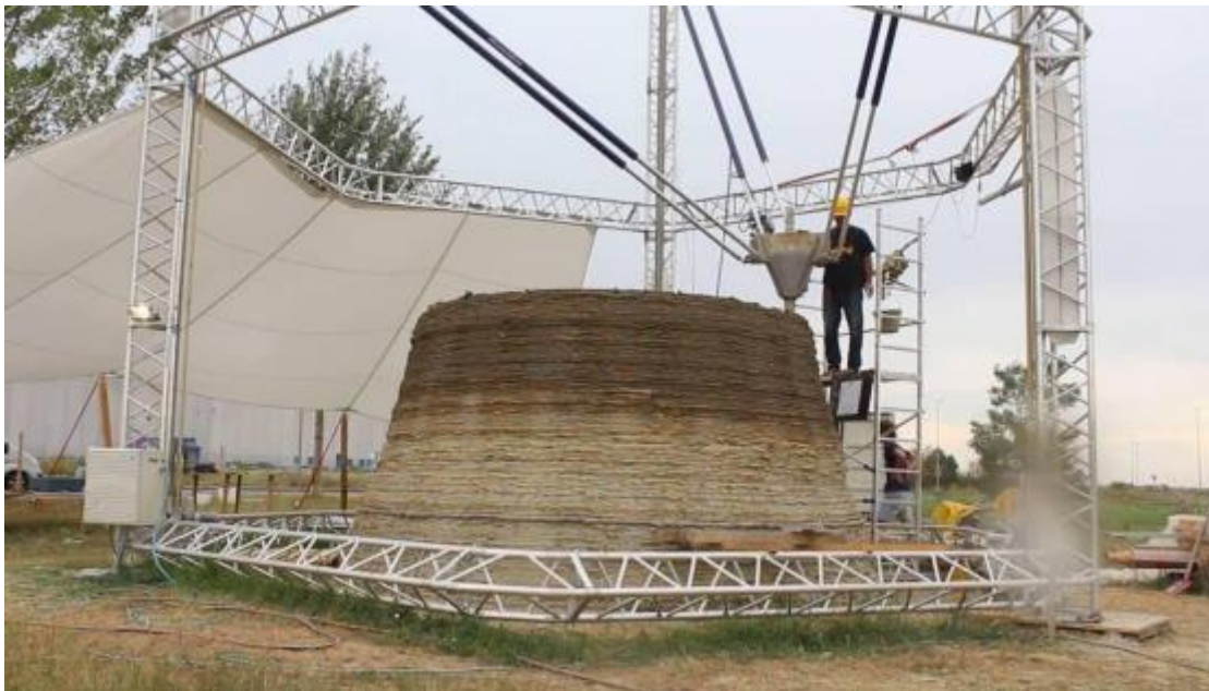
Figura 20 - Etapa Produção de Casa Utilizando a BigDelta. Fonte: (3dwasp, 2012).
