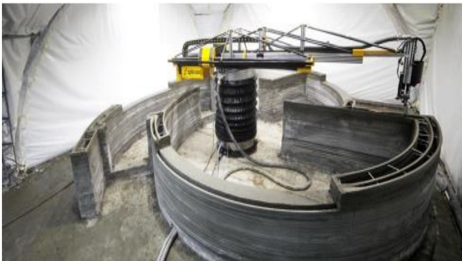
Figura 6 - Casa de Concreto Impressa em 3D.
