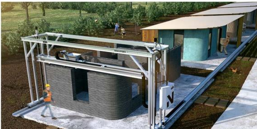
Figura 17 - Impressora Vulcan da ICON. Fonte – (ICON, 2017).
