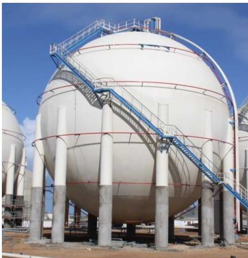
Figura 2 – Vaso de pressão esférico. Dillinger
