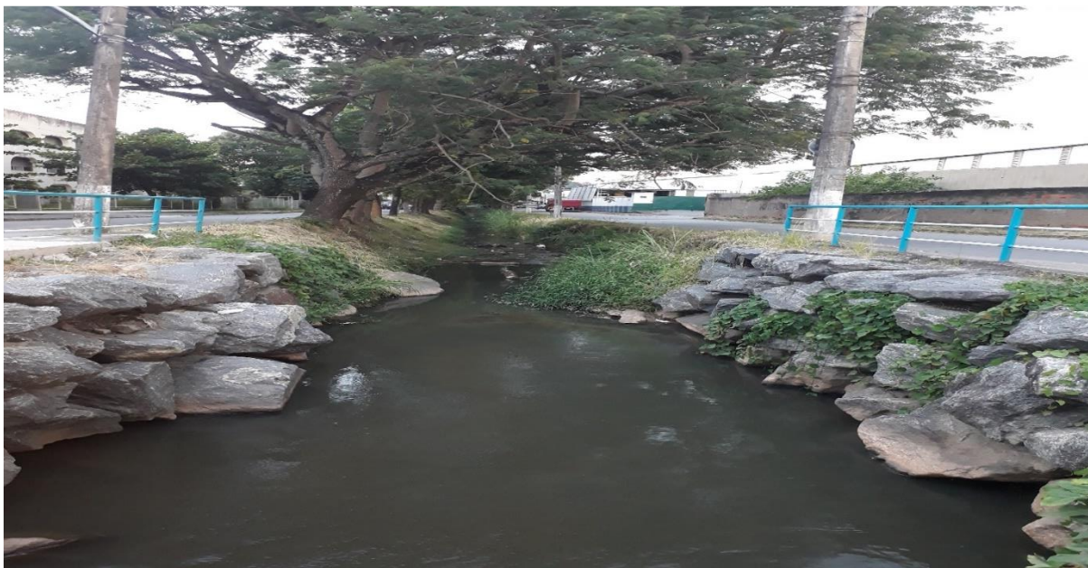
Figura 15-Situação atual do Córrego das Flores
