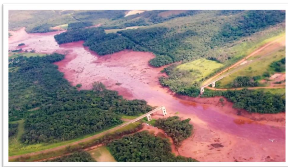
Figura 5 Rompimento de barragem em Brumadinho
