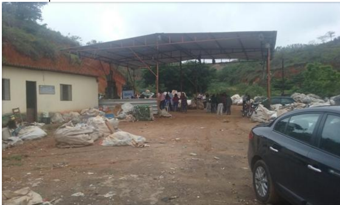
Foto 2 – Galpão do Lixão
