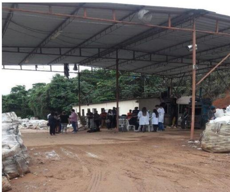
Figura 8. Galpão de acondicionamento dos materiais segregados.
