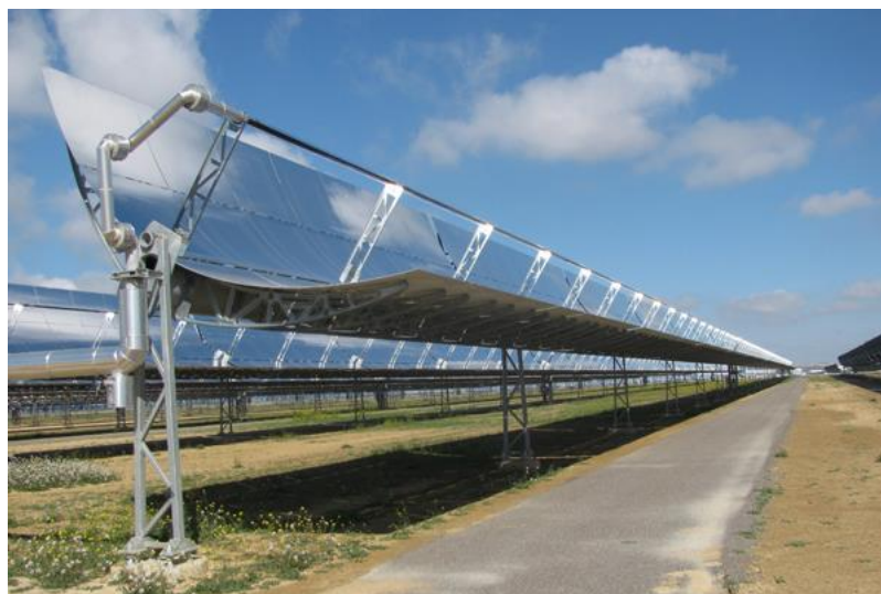
Figura 07: Sistema coletor distribuído, utilizando superfícies parabólicas. (SOLAR ENERGIA, 2015)
