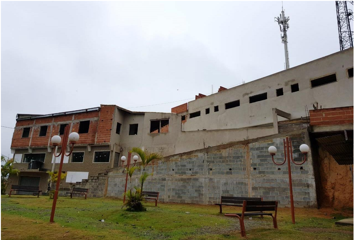
Figura 50: Empreendimento em construção. (DOS AUTORES)
