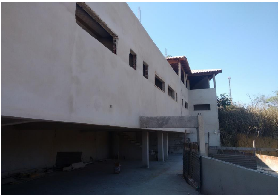
Figura 52: Suítes do empreendimento em construção. (DOS AUTORES)
