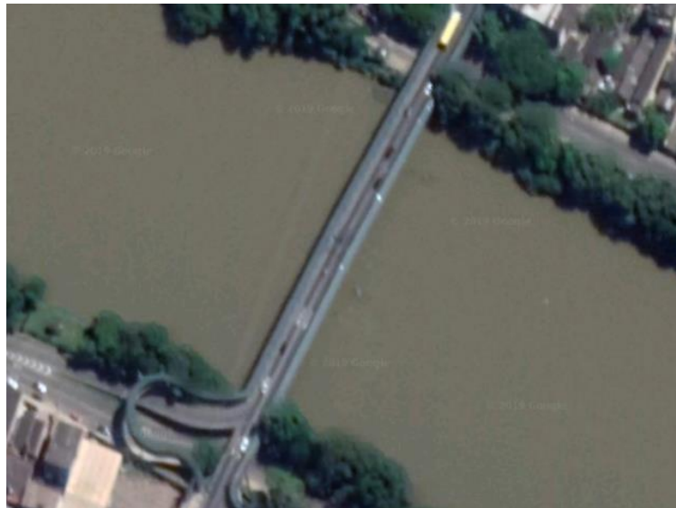
Figura 10: Imagem aérea da ponte Paulo de Frontim. Fonte: Google maps, 2019.
