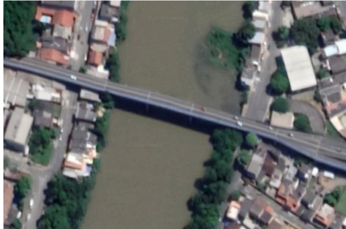
Figura 11: Imagem aérea da Ponte da Radial Leste. Fonte: Google maps, 2019.
