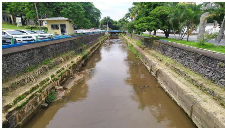
Figura 16 – Retificação e canalização do Ribeirão Brandão no bairro Vila Santa Cecília
