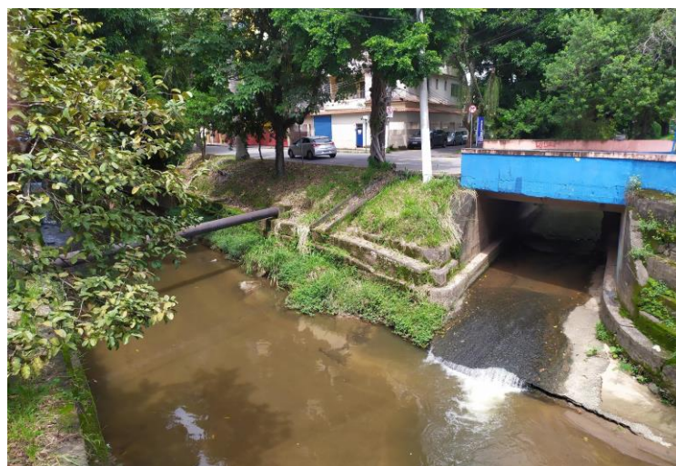
Figura 17 – Retificação e canalização do Ribeirão Brandão no bairro Vila Santa Cecília.
