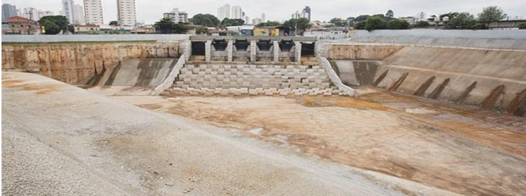
Figura 13 – Reservatório para retenção de água.
