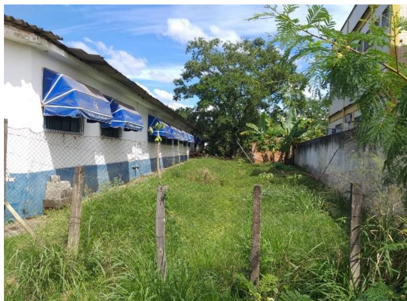
Figura 15 - Área Lateral da APAE - Vista Aproximada. Fonte: Autores, 2020.
