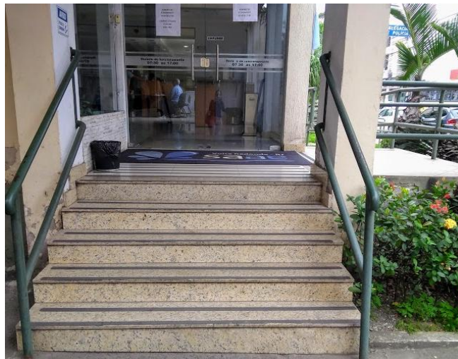
Figura 29: Escada de acesso ao edifício Fonte: Autores (2020)
