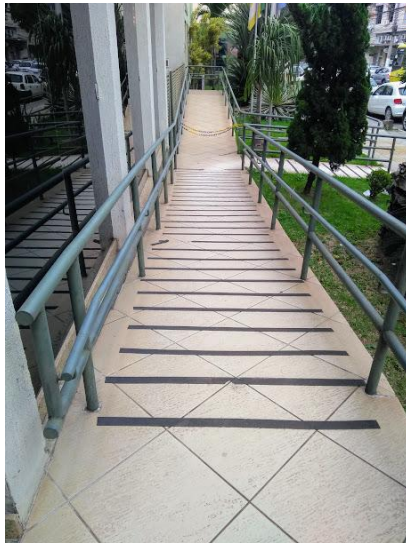
Figura 28: Rampa de acesso ao edifício Fonte: Autores (2020)
