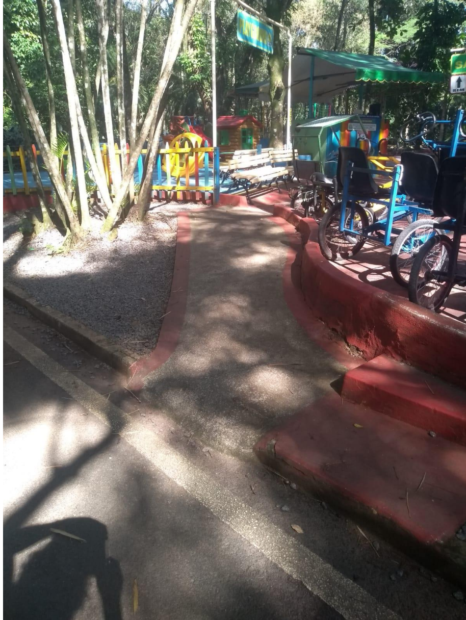
Figura 74: Acesso estreito ou por degraus às bicicletas e brinquedos para crianças menores Fonte: A autora
