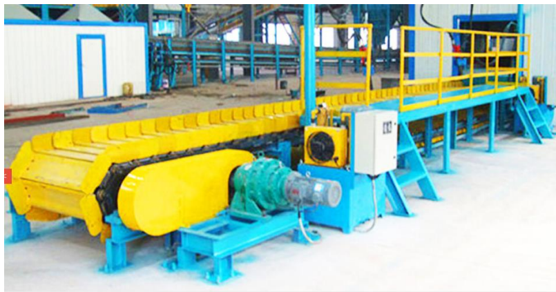
Figura 37 - Corrimão nas plataforma – Apostila AUMUND .
