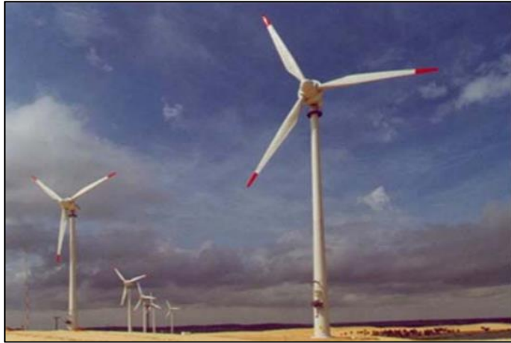
Figura 1 - Parque eólico conectado à rede - Parque Eólico da Prainha CE
