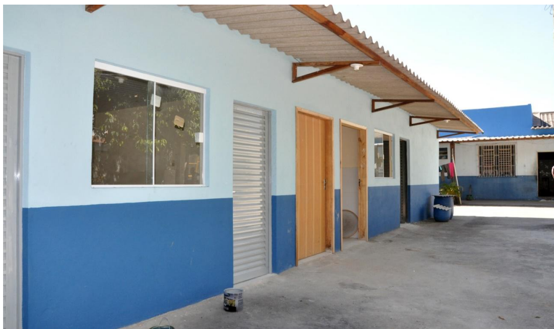
Figura 2. Salas Técnicas e ao fundo a entrada de um dos dormitórios.
