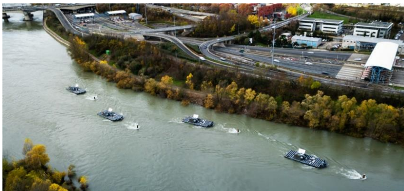
Figura 28 – Parque hidrocinético flutuante no Rio Ródano
