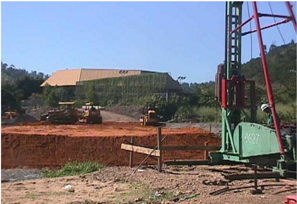
Figura 20: Execução do aterro na época da construção
