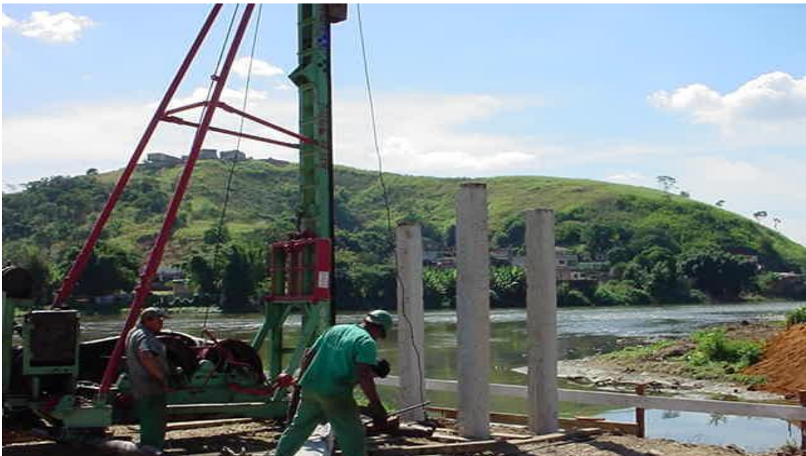
Figura 7: Implementação das estacas na construção da ponte
