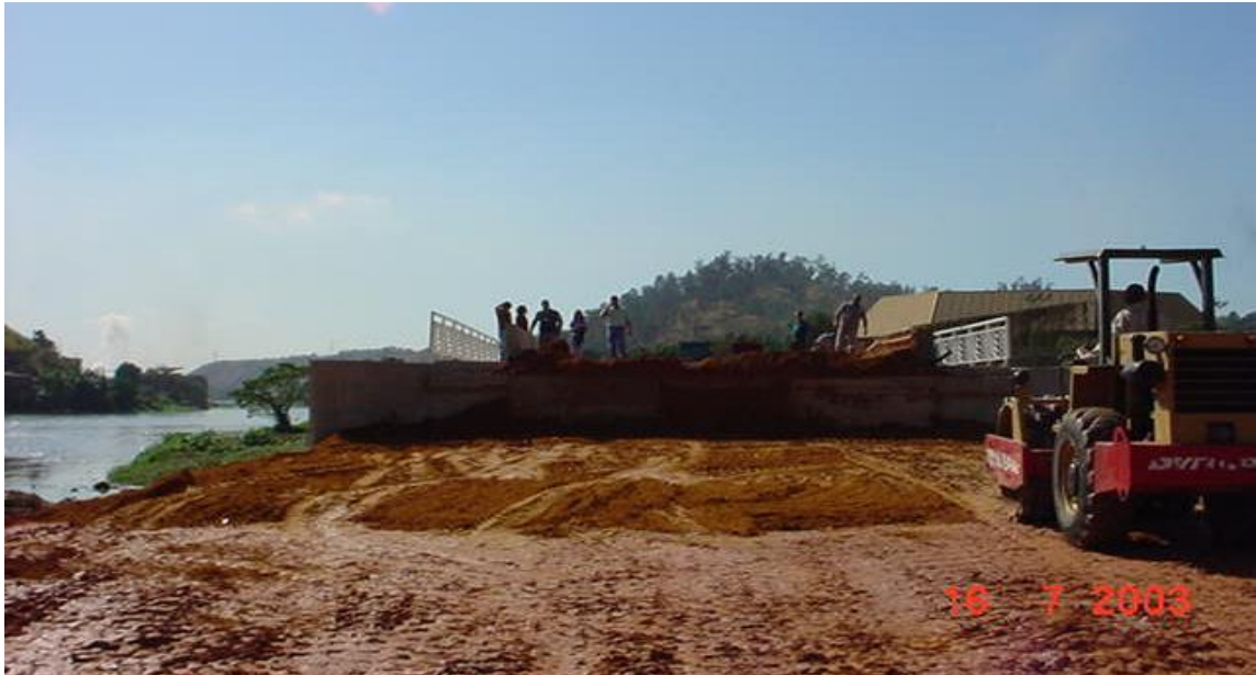
Figura 21: Construção do encontro
