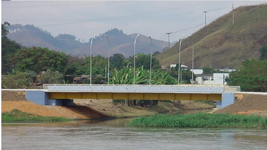
Figura 14: Vista longitudinal da ponte na época da inauguração
