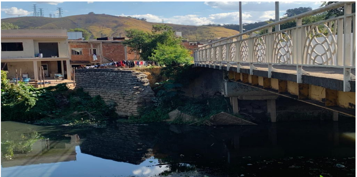
Figura 22: Situação atual da contenção
