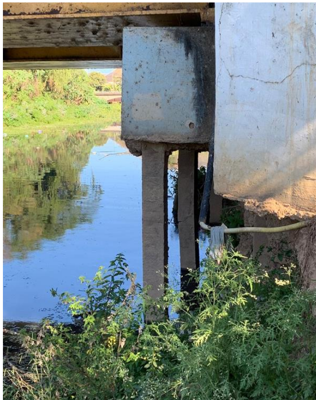
Figura 23: Situação atual da infraestrutura
