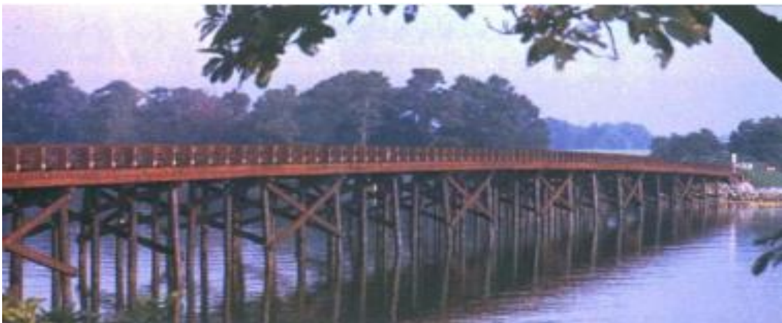
Figura 1: Ponte em madeira com vigas de peças separadas
