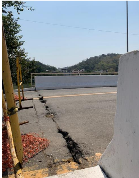
Figura 18: Junta de dilatação na ponte Vereadora Ruth Coutinho
